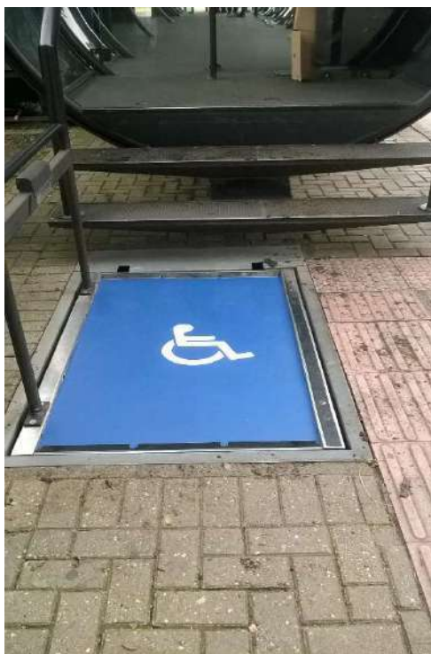
Figura 2- Elevador pronto para elevação
