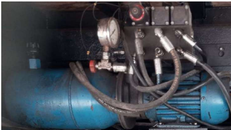
Figura 17 – Imagem sistema Óleo-Hidráulico Elevador GII
